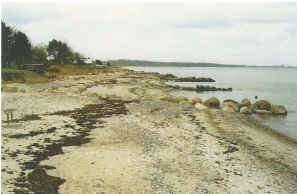
Foto 37: Fra st. 6200-6500 er opnået en fin kystbeskyttelse med kraftige stenhøfder, der dog ligger noget tæt.
