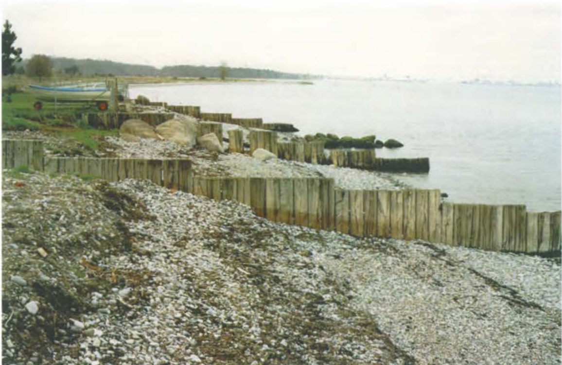
Foto 42: De sidste fire høfder på strækningen.
