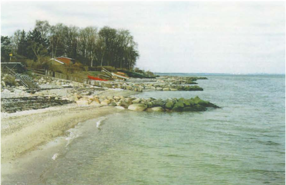
Foto 16: Foruden stenhøfderne er der på strækningen st. 2500-3500 anlagt en høfde af jernbanesveller. Der er oplægsplads for en badebro og der er både på stranden.
