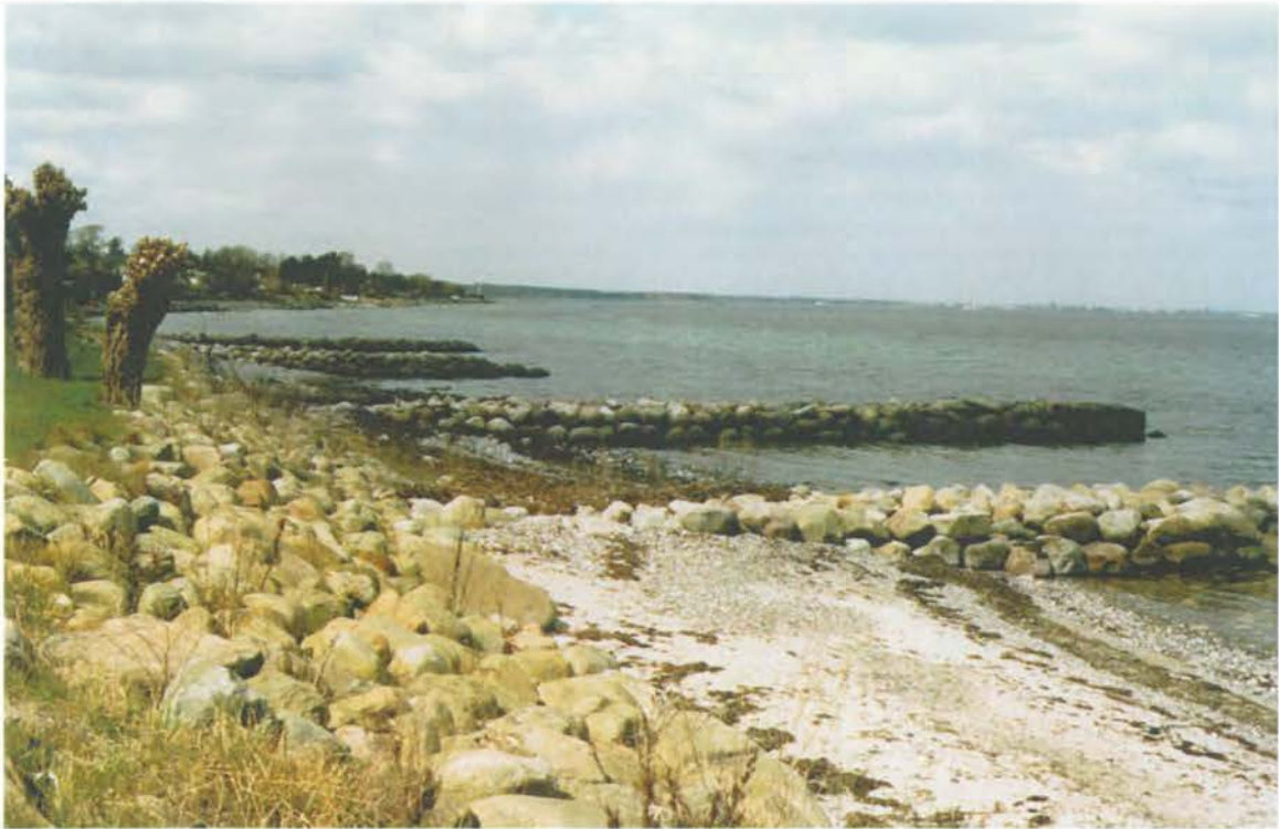
Foto 19: De tætliggende kraftige stenhøfder giver indtryk af en massiv kystfront. Flere steder samles der tang mellem høfderne.
