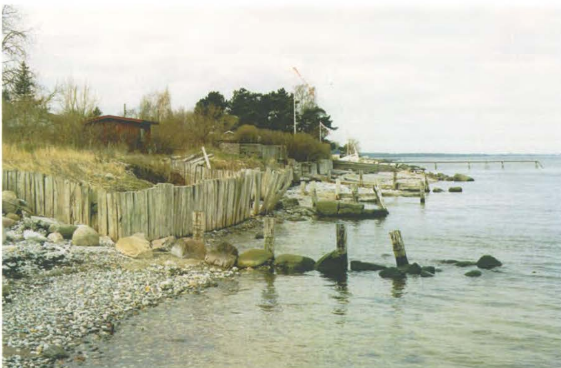
Foto 24: Jernbanesveller anvendt til beskyttelse af en matrikel, ca. ved st. 3820. Fotografiet viser også simple hofder af jernbanesveller, betonklodser og sten.
