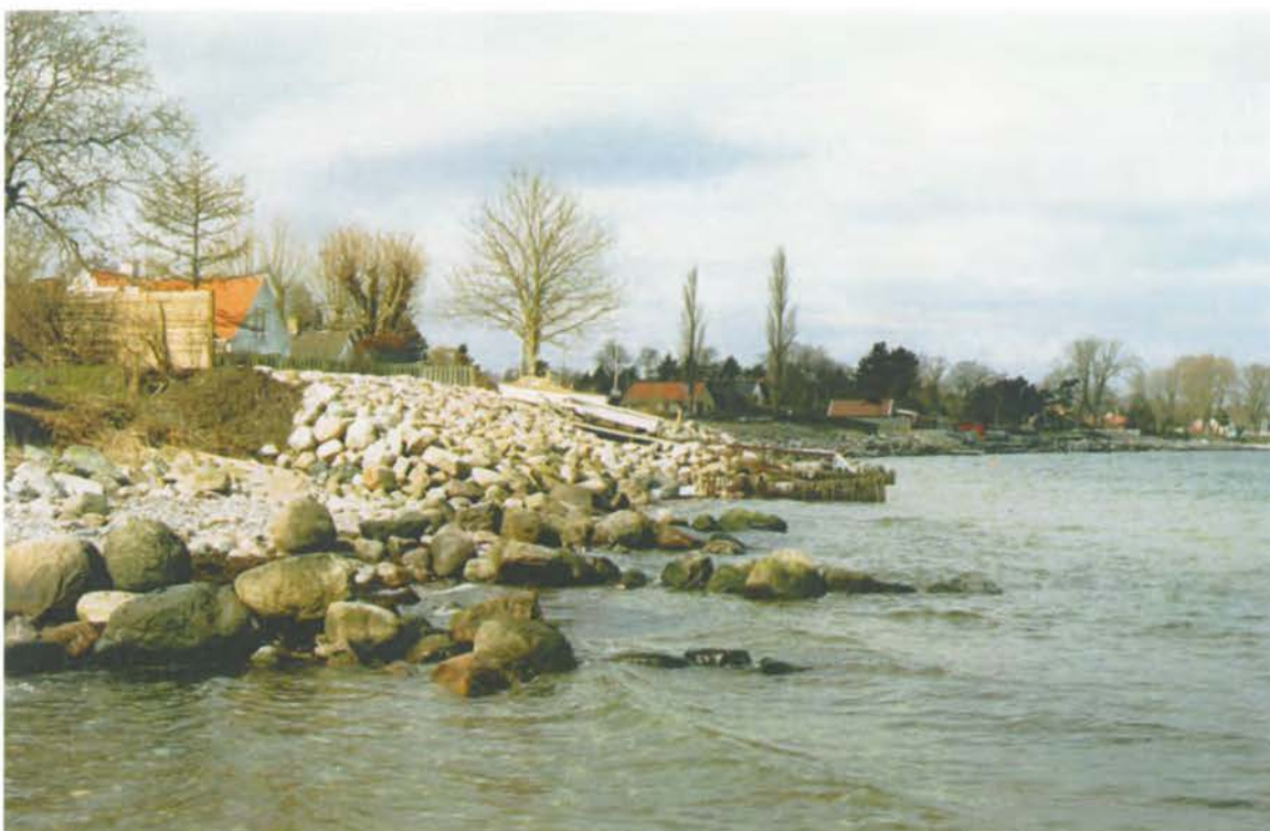
Foto 7: Flere steder er ejendomme beskyttet ved kraftige skræntfodsbeskyttelse, som her ca. ved st. 1370 hvor en massivstenskråning er opbygget af sten. Foranstenskråningen ses mindre træhøfder af jernbanesveller; oftest har høfderne ingen eller kun ringe kystteknisk effekt.
