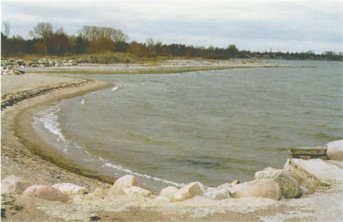
Foto 3: Vest for høfden i st. 550 findes indsejlingen til en lille jollehavn. Indsejlingen er i perioder delvis lukket som følge af tilsanding fra øst. Der aflejres ligeledes sand mellem høfden og indsejlingen. Oprenset sand bør føres rundt om pynten ved Vejs Ende, som ses til højre i baggrunden.
