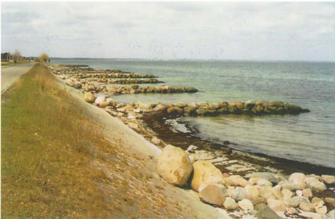
Nuværende forhold på strækningen ved st. 3000
