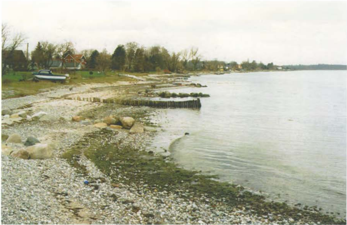
Foto 33: St. 5250. Utætte høfder kan ses på kysten. Høfderne virker ikke så voldsomme, men har en positiv effekt på fastholdelse af stranden, som er uden øvrige konstruktioner.
