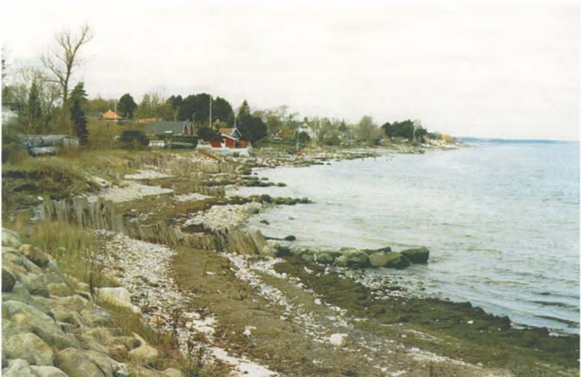
Foto 20: Fra st. 3500 og et par hundrede meter mod vest er kysten et rod af gamle høfder af sten og jernbanesveller, badebroer, bådeslidsker mv. De gamle høfder ved st.3500 ses at have en kystbeskyttende effekt.
