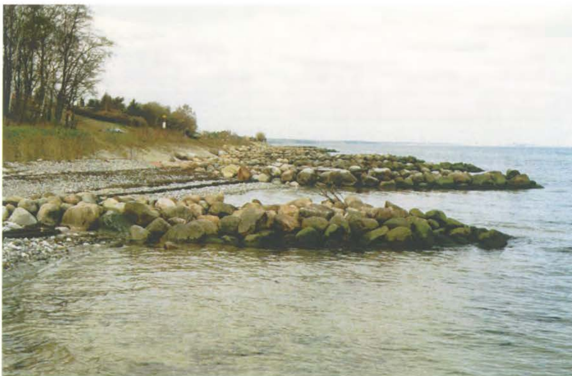
Foto 17: Et kig mod vest langs kysten ca. fra st. 2800. De mange kraftige stenhøfder giver indtryk af en ikke-passabel kyst, der ikke indbyder til rekreative formål. Vejen ligger få meter inden for høfderne og beskyttes af en skråning med SF-sten.
