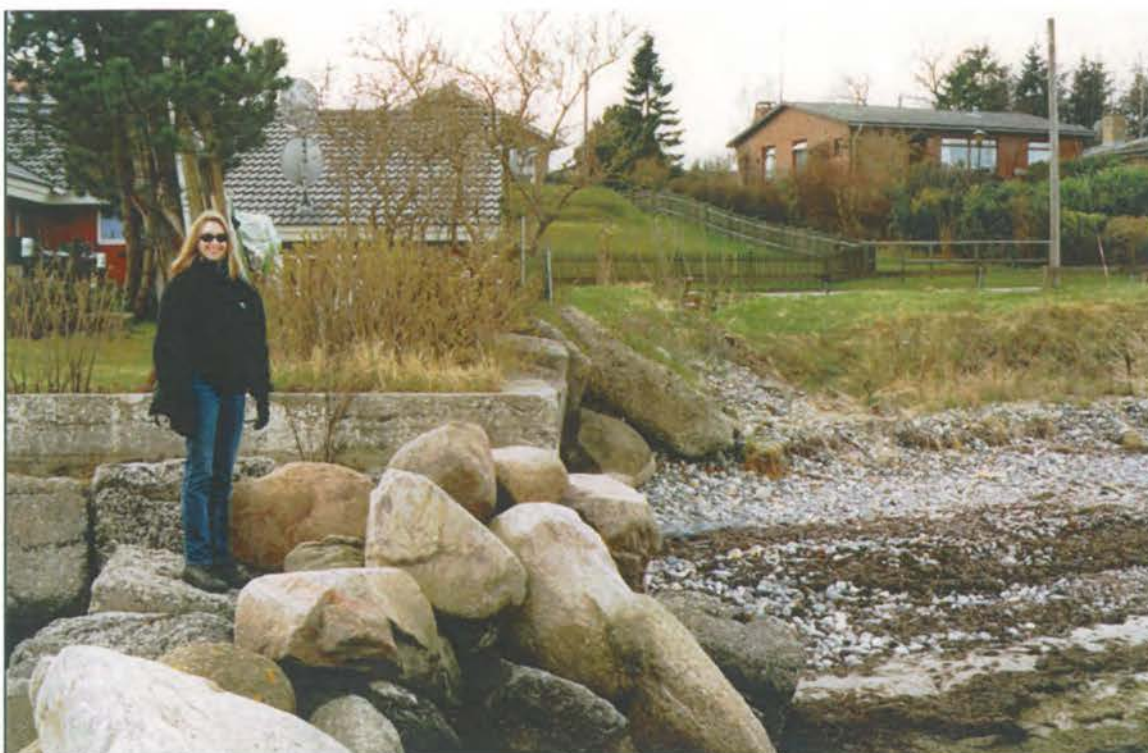
Foto 23: Besværlige passageforhold ved hofde af betonblokke og natursten. Til højre ses en naturlig bagstrand med ral og græs op mod Kystvejen.
