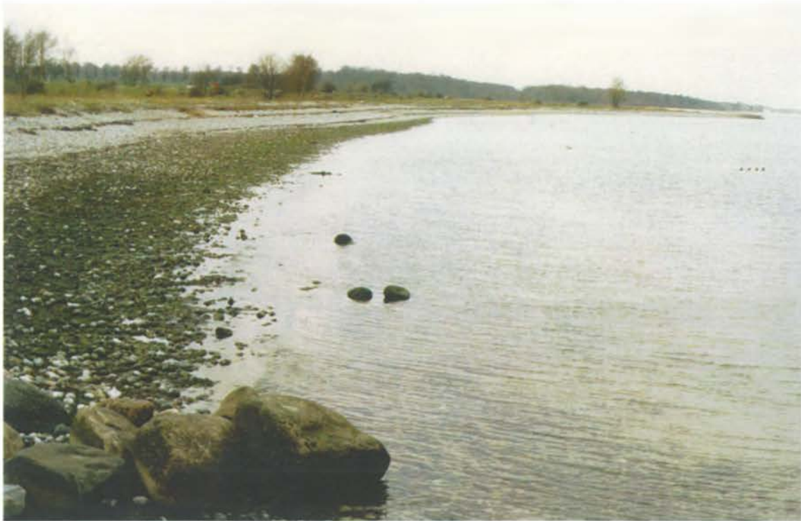
Foto 43: Vest for strækningen frem mod Odden er der udviklet en naturlig kyst, der kan tage læsideerosionen fra kystbeskyttelsen på den 7 km lange strækning. Der er ikke behov for kystbeskyttelse. Området anvendes som rekreativt område.
