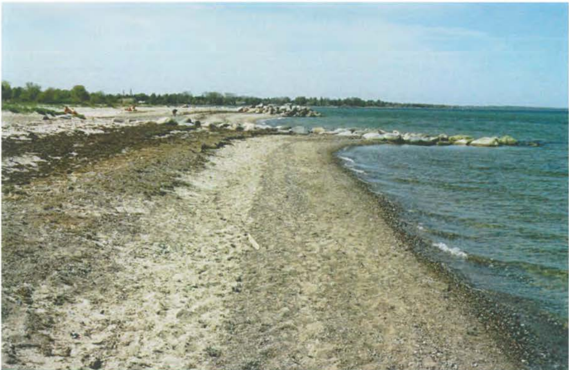
Foto 2: Stranden er bred på de østligste ca. 500 m af strækningen. Høfden, som formodentlig dækker over et udløb, i st. 450 forårsager i mindre udstrækning luvsideaflejring mod øst og læsideerosion mod vest. Kystlinien vil ikke ændres væsentligt, hvis høfden fjernes.
