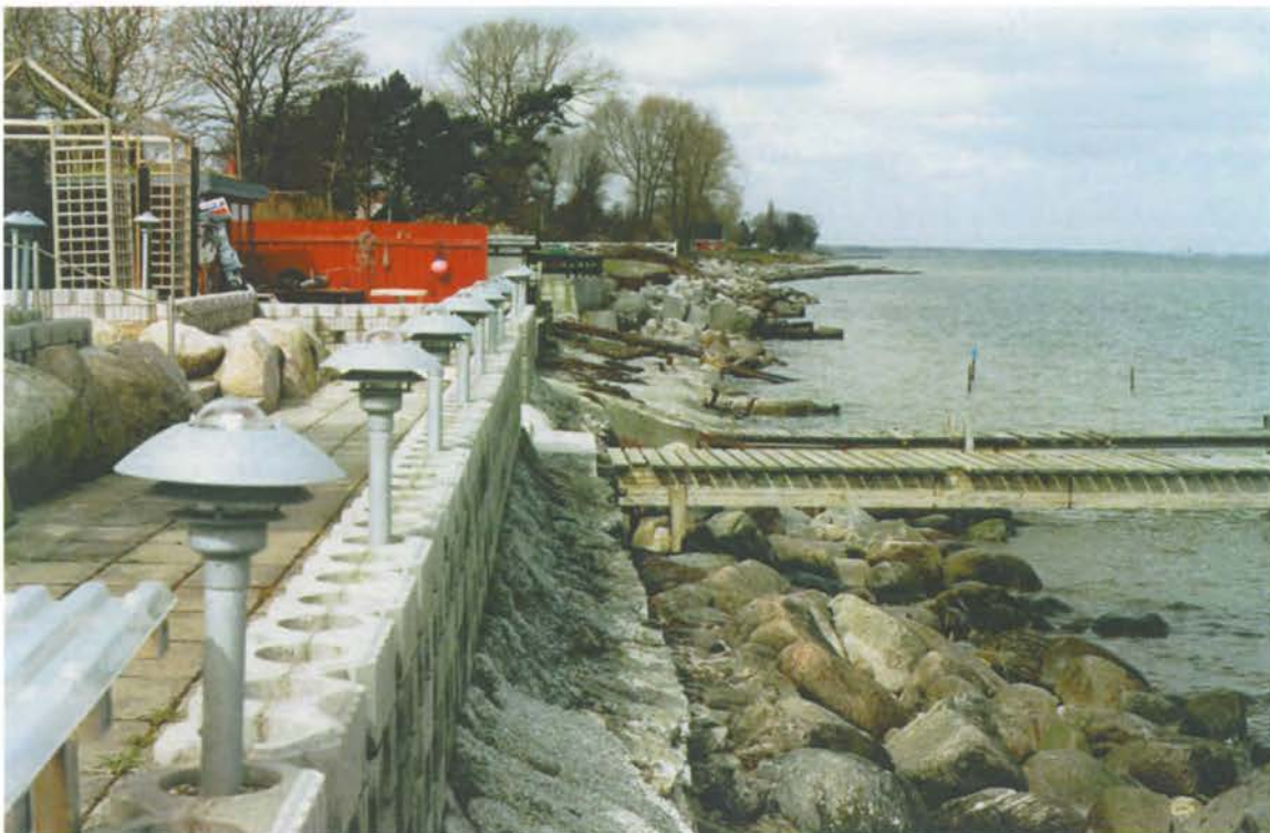
Foto 10: Matriklerne går helt ned til vandlinien og er beskyttet forskelligt, her med beton og yderst sten. Kystbeskyttelsen giver samlet et rodet billede af kysten.
