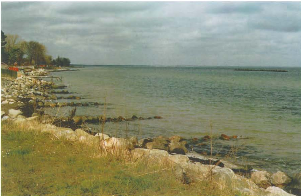
Foto 9: Ved st. 2000 er placeret en bølgebryder. Den er fra 1926, er 140 m lang og ligger 190 m fra kysten. Fotografiet viser bølgebryderens effekt: en udbulning af sand på kysten ud for bølgebryderen samt lavvande mellem kysten og bølgebryderen. Forrest i billedet ses høfder med kun få sten, den kysttekniske effekt heraf er begrænset.
