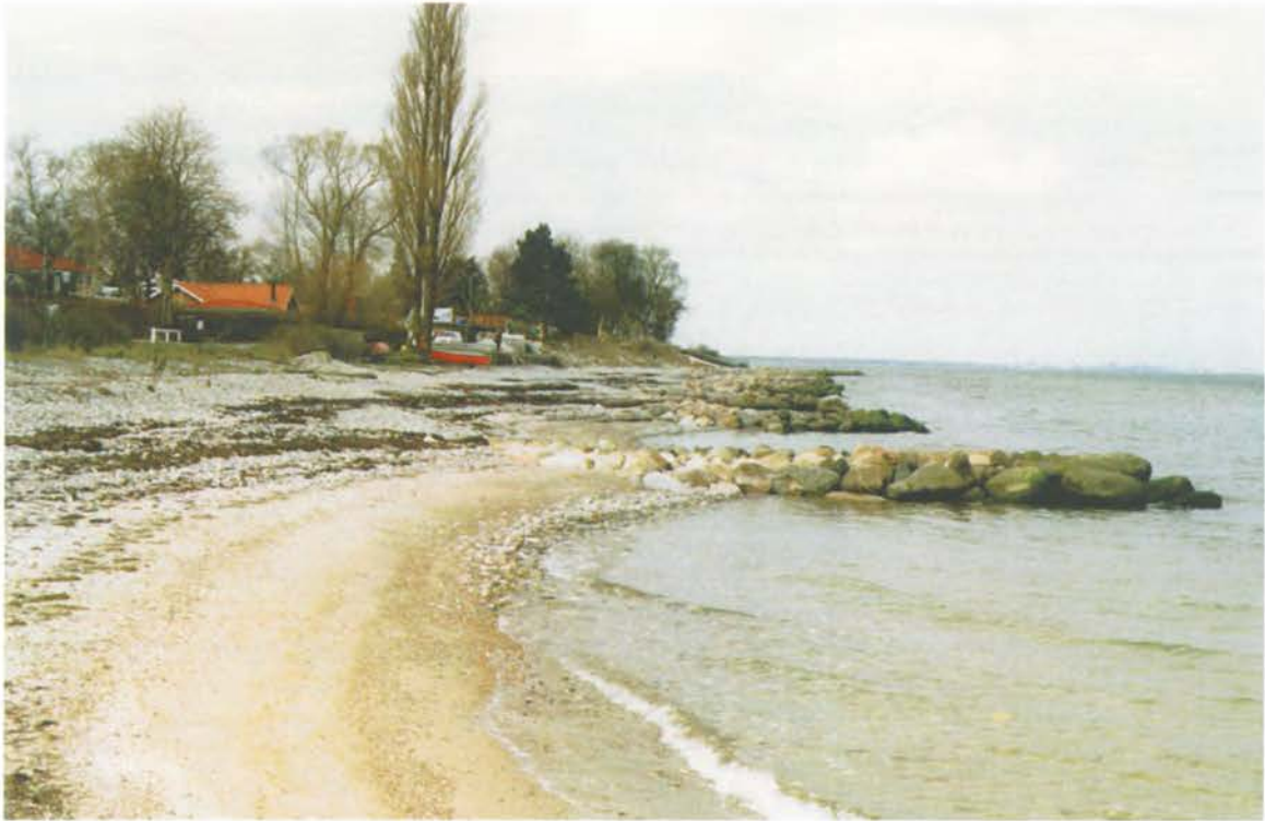
Foto 15: På den ca. 1 km lange strækning fra st. 2500-3500 er anlagt kraftige høfder af sten. Høfderne fastholder en del materiale, men er udført unødvendigt brede og udenfor kystlinien for høje.
