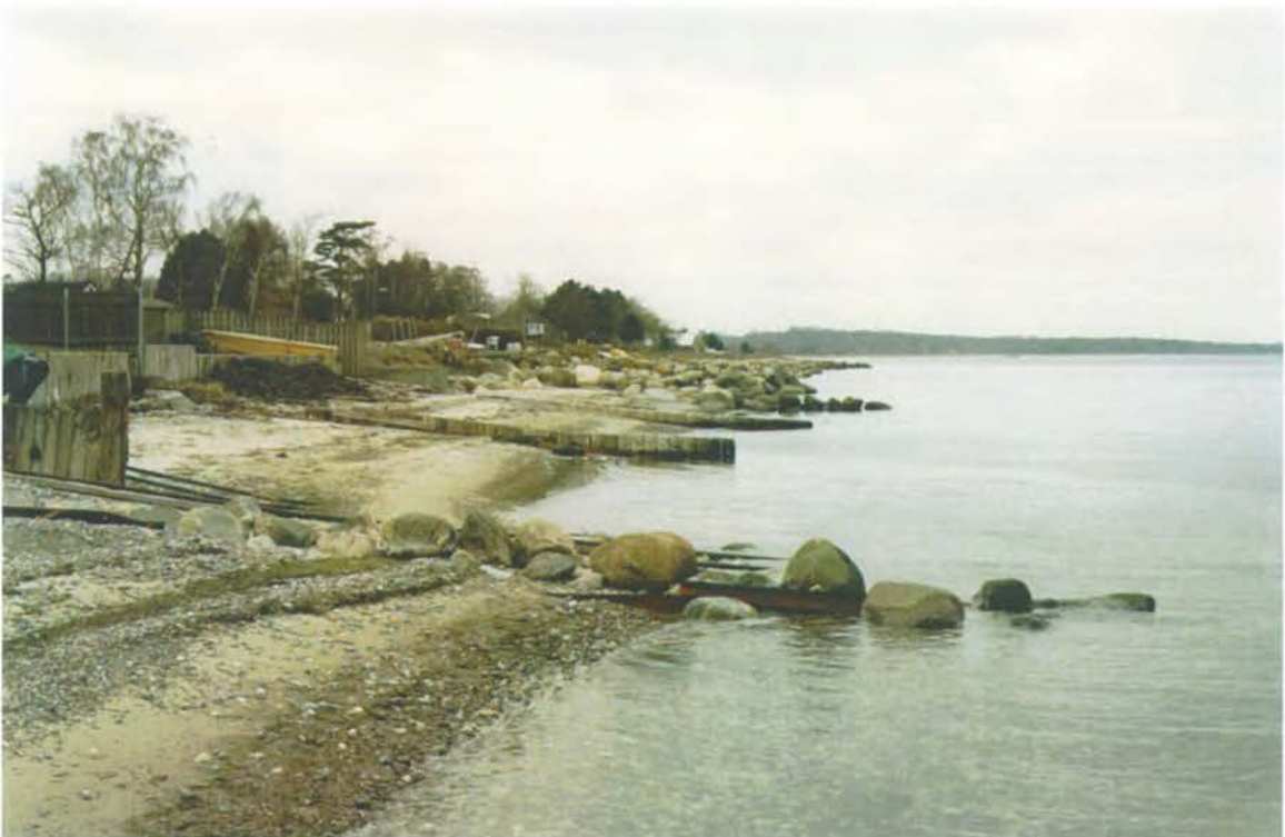
Foto 36: Bådeslidsker og gamle høfder blokerer og er til gene for eventuelle forbipasserende. Det anbefales at rydde op på kysten. Det ses også at træhøfden er tilpasset stranden (eller omvendt) og at det visuelle indtryk er enkelt og acceptabelt.
