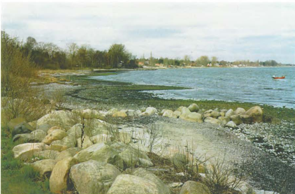
Foto 6: Fra ca. st. 1050-1350 kan bølger og strøm frit erodere kysten. Grundet den flade stenede strand er bevoksningen tæt på kystlinien. Rester af gamle træhøfder kan ses på stranden, konstruktionerne har ingen kystteknisk effekt og medvirker til en rodet strand.
