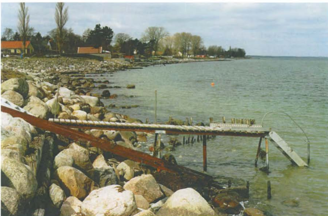
Foto 8: På lange strækninger er kysten svær at passere som følge af rester af gamle ineffektive høfder, parallelværker, badebroer, båderamper ogstenskråninger ned til vandlinien. Kysten er med andre ord rodet og ikke sikret hensigtsmæssigt; foto fra ca. st. 1500.
