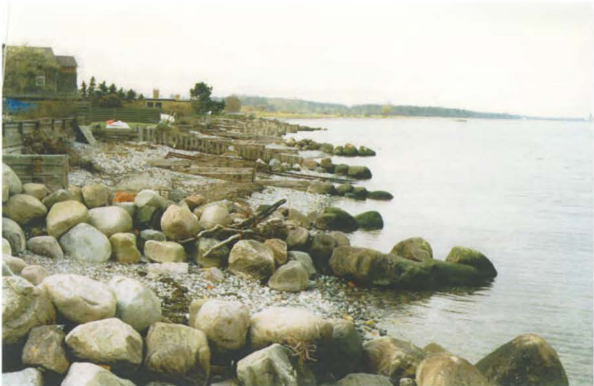
Foto 41: Den vestligste del af kyststrækningen er præget af mange sten- og træhøfder, der har en vis kystteknisk effekt ved at fastholde en ralstrand.
