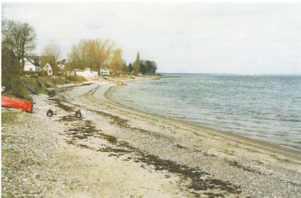
Foto 13: Bølgebryderen har stor effekt på kysten, også vest for (nedstrøms) hvor der på en strækning på ca. 100 m er aflejret materiale.
